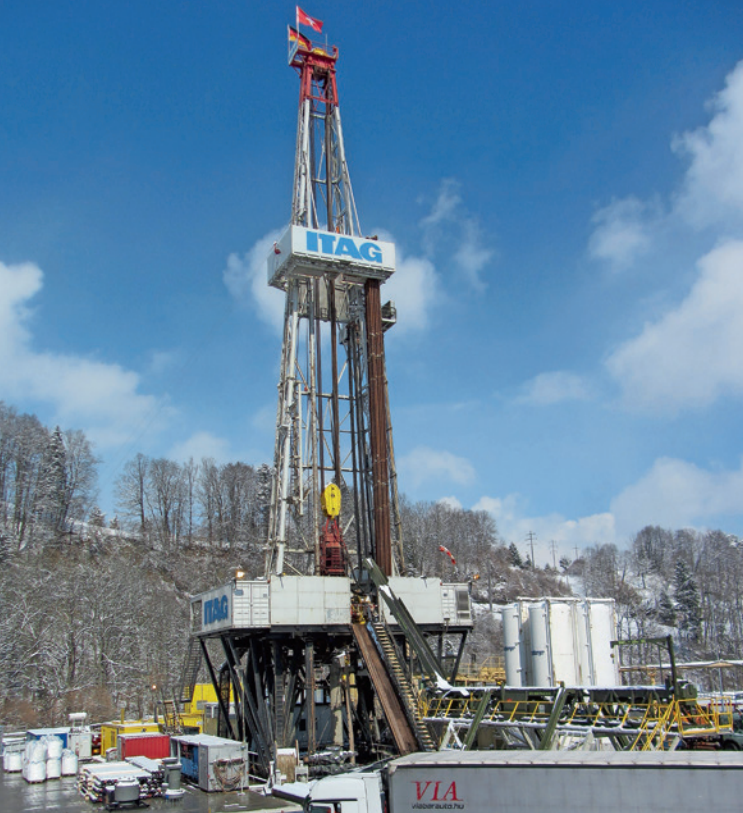
Der 58 m hohe Geothermie-Bohrturm im Sittertobel/St.Gallen. Bild Beat Moser 2013
