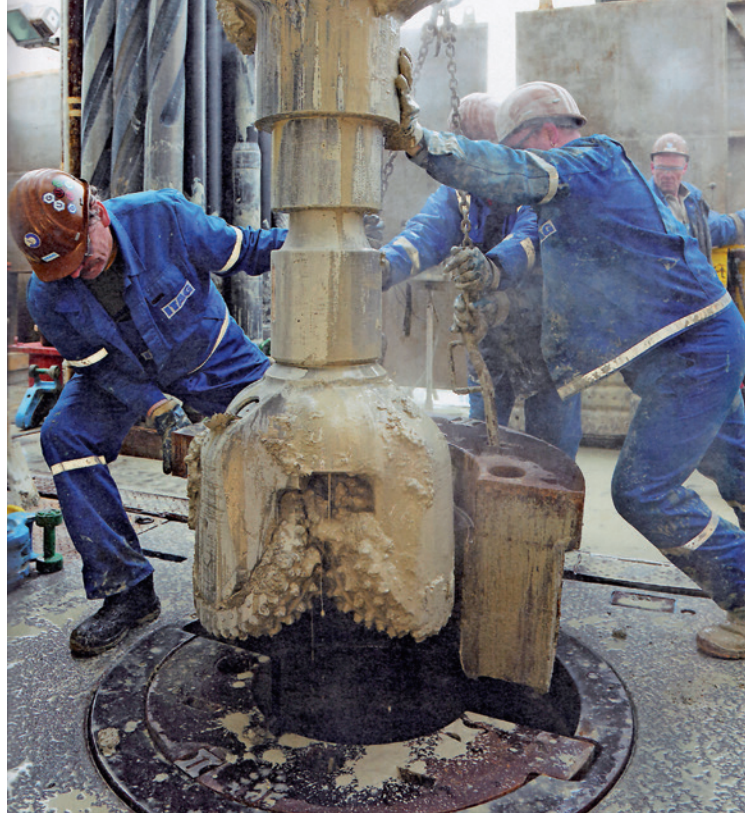
Positionieren des Bohrmeissels bei der Geothermie-Bohrstelle im Sittertobel. Bild Michael Breu
